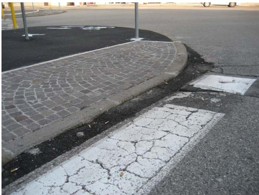
*All'assoluta povertà di segnaletica di questa pista ciclabile, si aggiunge che **la pavimentazione nell'attraversamento stradale è fortemente degradata con avvallamenti, lacune e croste nel manto bitumato, i nuovi cordoli risultano dei piccoli e fastidiosissimi spigoli sui quali battono ogni volta i cerchioni delle biciclette.***
